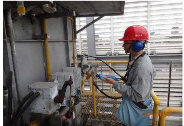
05.2014 風控處曾迪農工程師執行超音波測漏檢查輔導。
