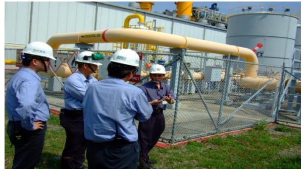
05.2015 台南天然氣發電廠防爆電氣現場查核與輔導-右一林慶峰主任工程師
